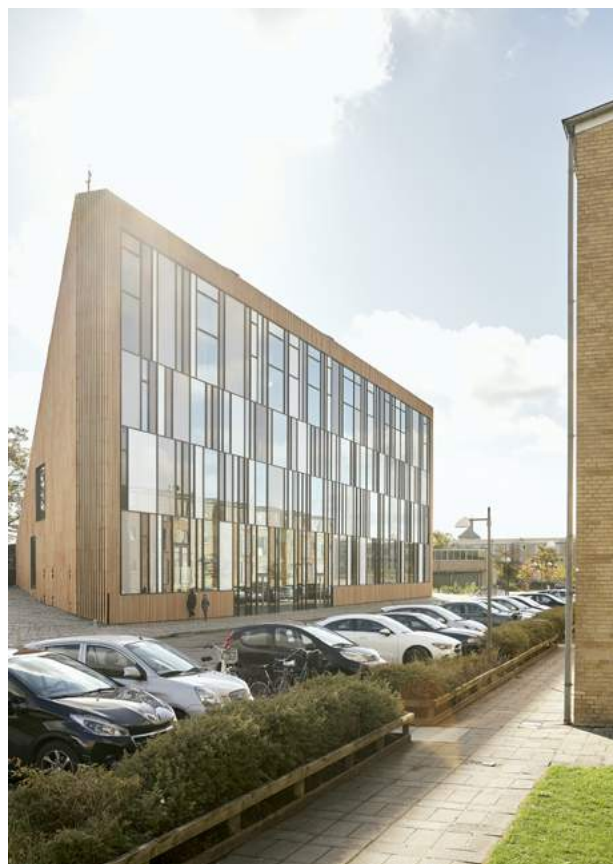
Tingbjerg: Nyt bibliotek/kulturhus med formgivning og materialer som adskiller sig fra boligområdets eksisterende bebyggelse.
