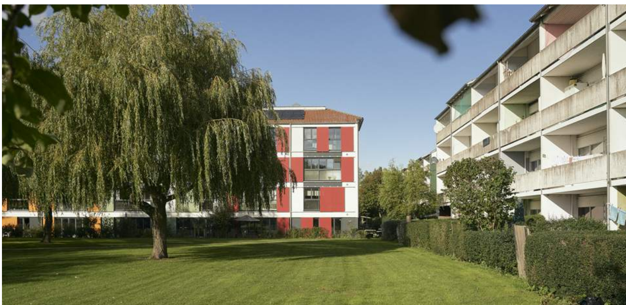
Boligbebyggelse i Gadehavegård
